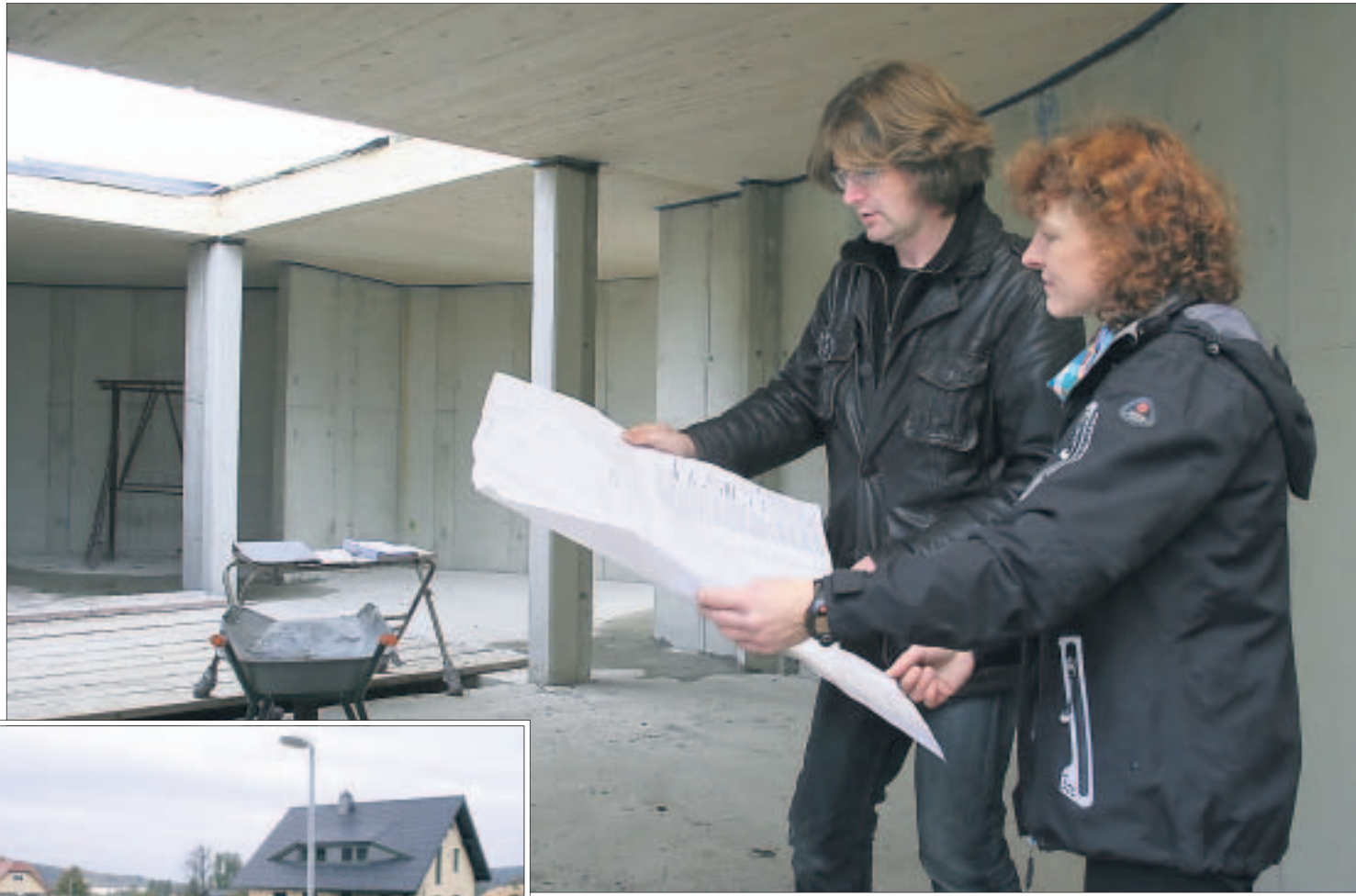
Die Sohlander Gynäkologin Andrea Neururer schaut sich mit ihrem Architekten Peter Garkisch auf der Baustelle die Pläne für die neue Praxis an. Neben dem Rohbau türmen sich zurzeit Feldsteine auf, die später wieder Verwendung finden sollen (kl. Foto).
